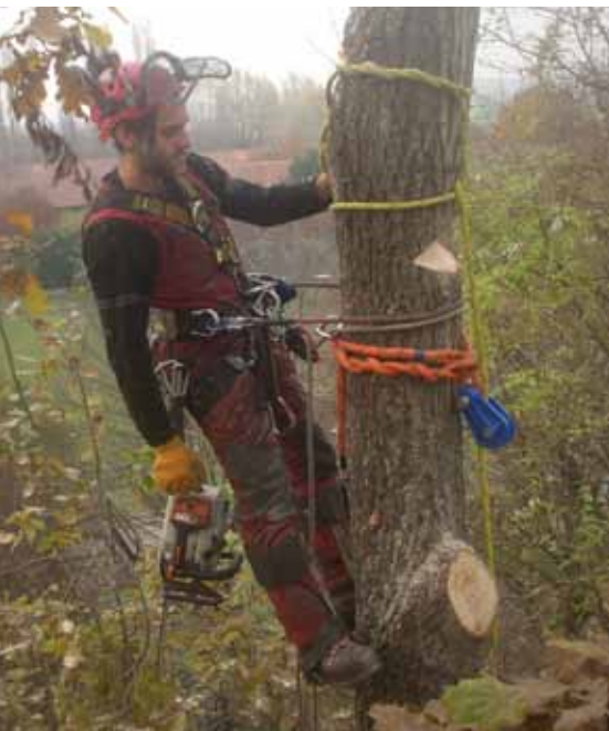
Posizione corretta per lo smontaggio frizionato del fusto
