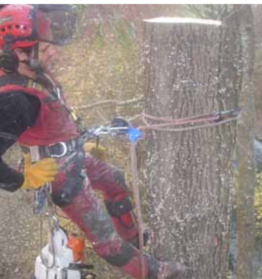
Posizionamento del climber con corda di lavoro e longe antitaglio strozzate sul fusto in direzioni opposte (lato strozzatura longe antitaglio)
